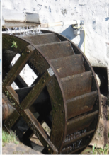
La roue à auge(s) du moulin du Got à Saint-Léonard de Noblat a été refaite en 1992. À l'origine, il y avait trois roues pour faire fonctionner le moulin.
