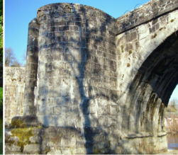
Le pont de Noblat présente un avant-bec en amande, forme caractéristique de ces ouvrages médiévaux en Limousin. La colonnette est par contre propre au pont de Saint-Léonard.
