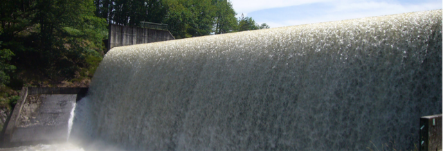
La plupart des barrages de la Maulde sont munis de crêtes déversantes qui permettent un débordement lorsque la réserve est pleine.
