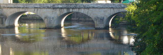
À Saint-Léonard de Noblat, le Pont Neuf fut érigé hors de la modernisation de la route de Limoges, à la fin du XVIII e siècle.
