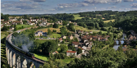
Long de plus de 400 mètres et doté de 22 arches, le viaduc de Saint-Léonard de Noblat fut construit pour permettre le passage de la ligne Limoges-Eymoutiers.
